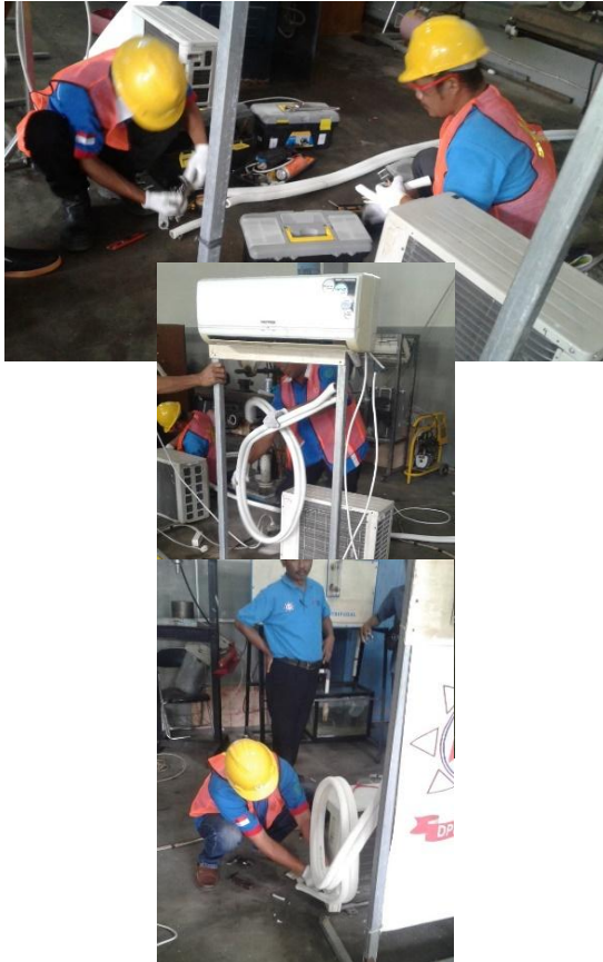
Gambar 3. Sosialisasi SOP dan praktek pemasangan, perawatan, dan perbaikan AC
